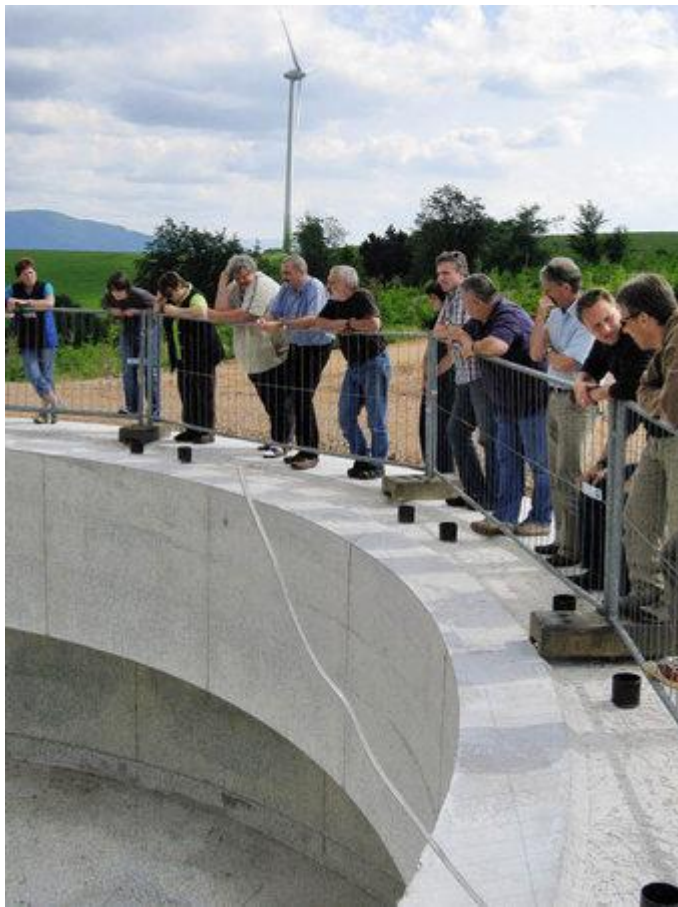
Stolze 22 Meter Durchmesser: Die Delegation der Elzacher Freien Wähler inspiziert das Fundament des fünften Windrades in Freiamt. Foto: Joachim Disch
